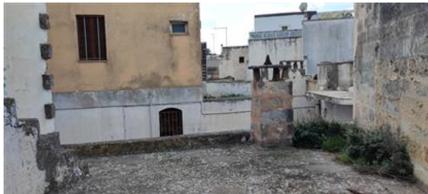
lastricato solare con vegetazione infestante il canale di scolo delle piovane
