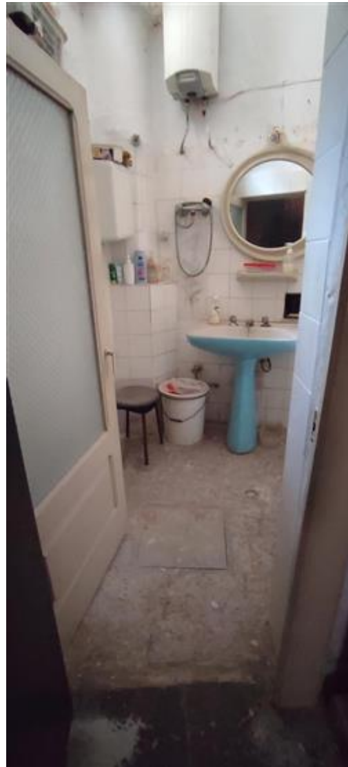
w.c. con pozzetto di ispezione del pozzo nero sul pavimento
